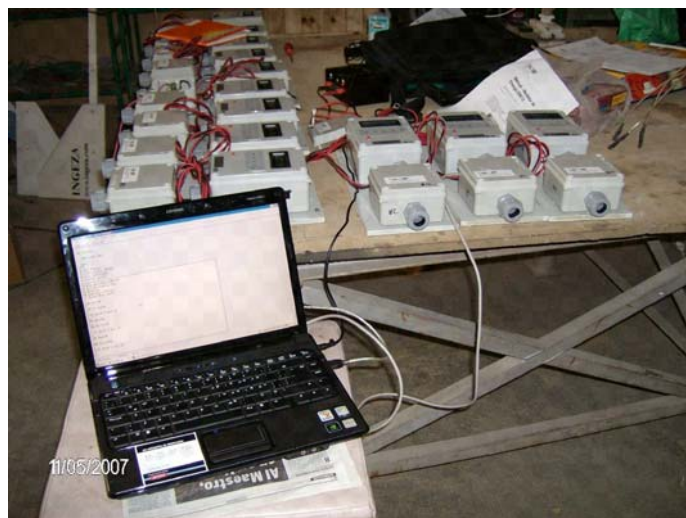
Figura 3 – Configuración Equipos EM/12 para PERMER – Proyecto Piloto
