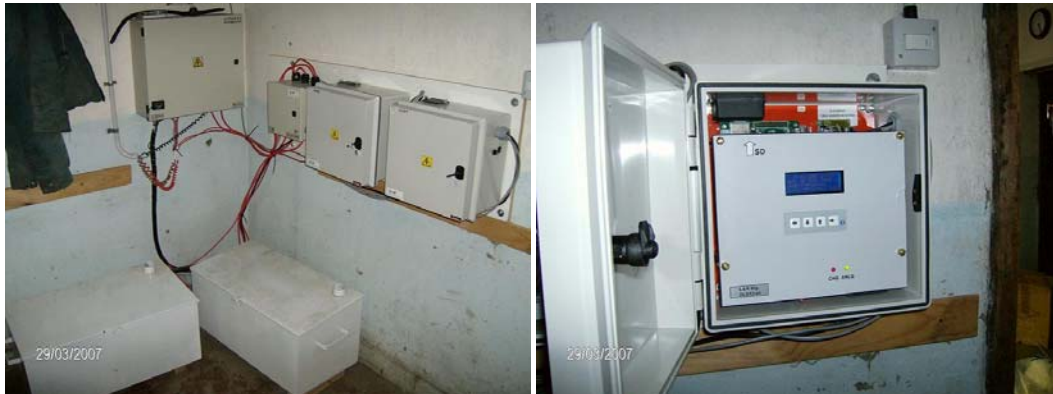
Figura 2 – Instalación del conjunto PWRC-DL/12 – Ñorquino y Detalle de Sistema DL2 /12 interior
